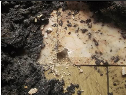
Photo n° PhA016 Localisation : 1er étage - Séjour Ouvrage : 5 - Planchers et planchers techniques - Revêtements de sols Partie d'ouvrage : Colle de carrelage Description : Colle de carrelage
