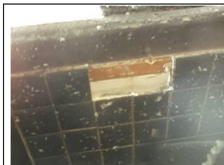
Photo n° PhA020 Localisation : 1er étage - Cuisine Ouvrage : 3 - Parois verticales intérieures - Revêtements de murs, poteaux, cloisons, gaines, coffres Partie d'ouvrage : Colle de faïence Description : Colle de faïence
