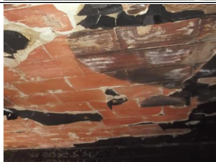
Photo n° PhA021 Localisation : 1er étage - Cuisine Ouvrage : 4 - Plafonds et faux plafonds - Plafonds Partie d'ouvrage : Plâtre + revêtement sur brique Description : Plâtre + revêtement sur brique
