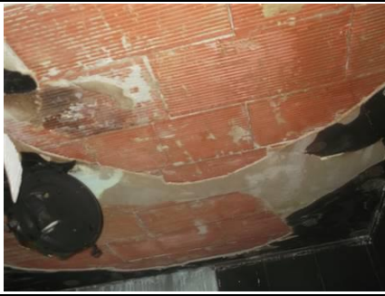
Photo n° PhA010 Localisation : 1er étage - sde Ouvrage : 4 - Plafonds et faux plafonds - Plafonds Partie d'ouvrage : Enduit à base de plâtre lissé ou taloché Description : Enduit à base de plâtre lissé ou taloché sur brique
