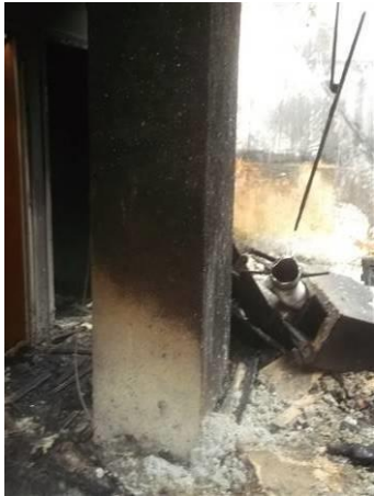
Photo n° PhA015 Localisation : 1er étage - Pièce Ouvrage : 3 - Parois verticales intérieures - Murs et cloisons maçonnés Partie d'ouvrage : Enduit granuleux Description : Enduit granuleux sur poteau
