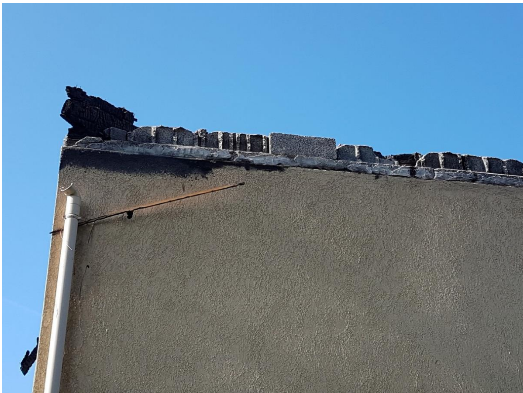
Tête de maçonnerie
