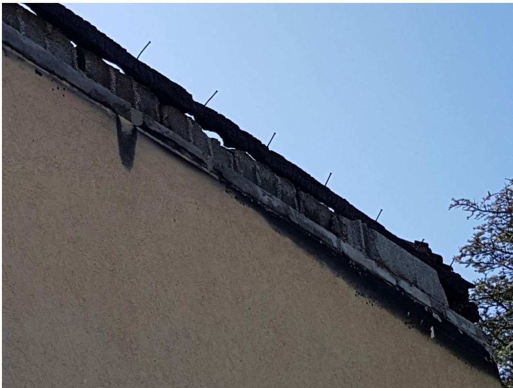
Tête de maçonnerie
