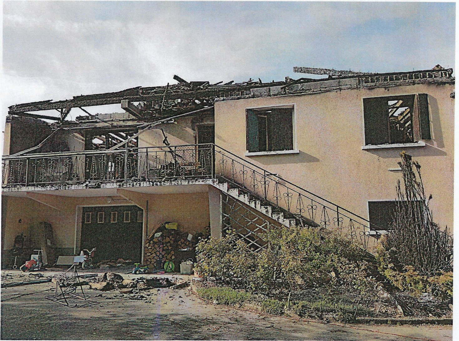
Toiture après rinister
